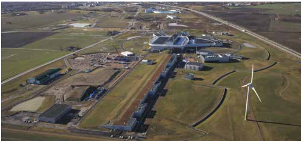
Abbildung 1: Luftbild der European Spallation Source (ESS) im schwedischen Lund. (Bild: Perry Nordeng/ESS)
