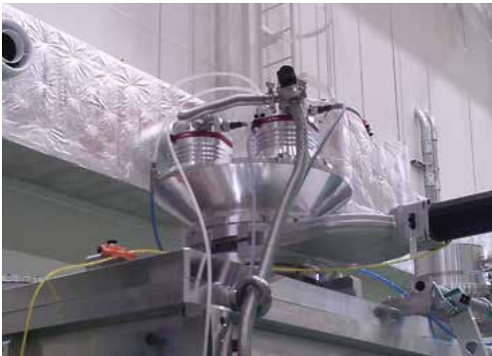
图片 3 和图片 4：安装在欧洲 XFEL 的 HiPace 涡轮分子泵
