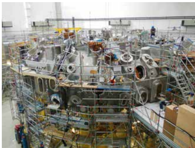
Wendelstein 7-X 反应堆主安装阶段完成前不久, 摄于 2014 年 3 月 ( 图片 : IPP, Beate Kemnitz )
