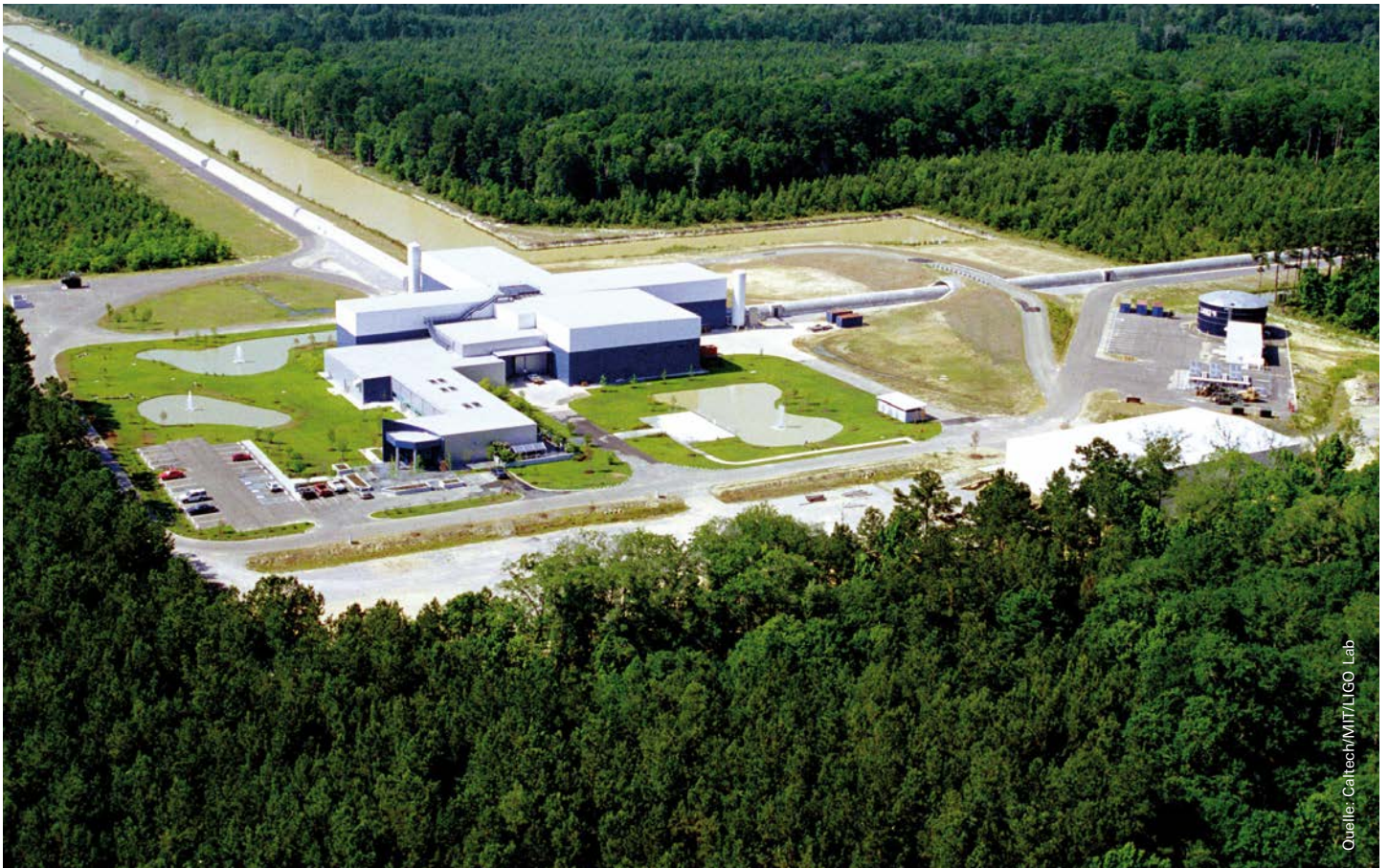
Abb. 1: Blick auf einen der beiden 4 Kilometer langen Vakuumröhren-Arme des LIGO-Detektors in Louisiana
