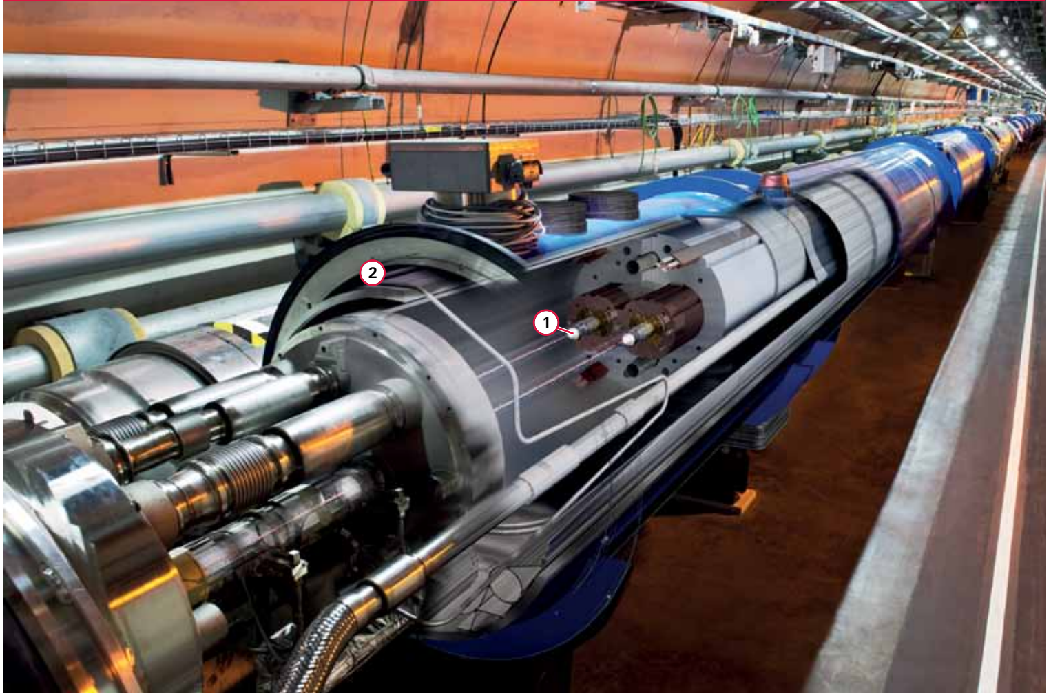
LHC加速器工程 (由CERN提供)
